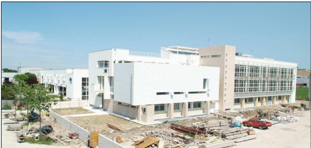
Figura 3: Foto esecuzione cantiere Centro Direzionale
